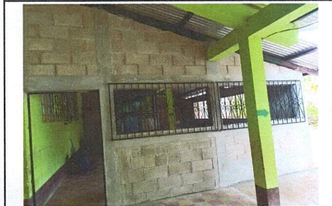
Foto 3: Mejoramiento de cerramiento y puerta de instalación de ambiente de párvulos 2, sección B
