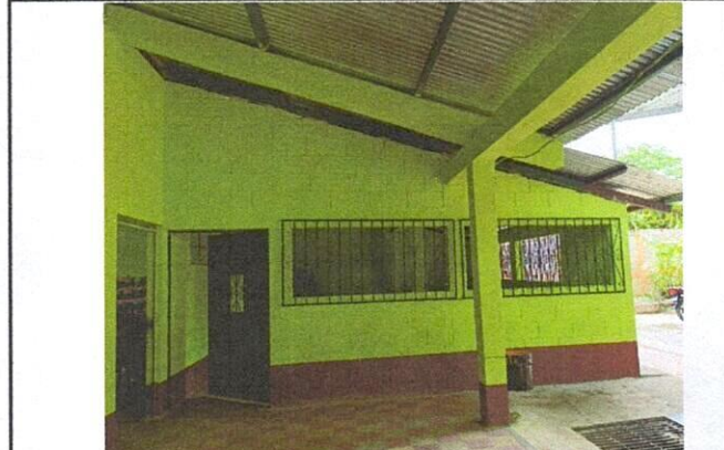
Foto 4: Mejoramiento de cerramiento y puerta de instalación de ambiente de párvulos 2, sección B
